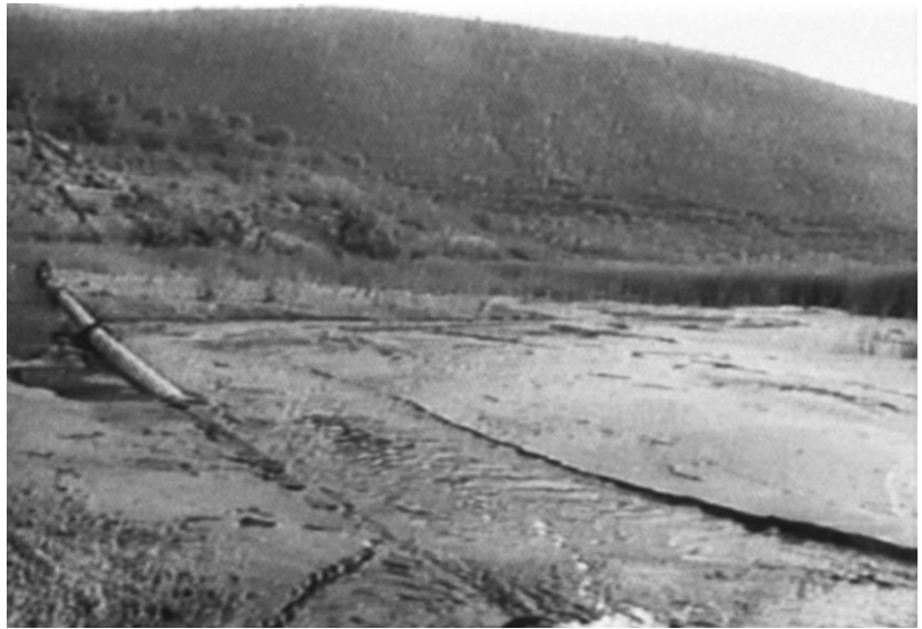
▲廃液と鉱さいはパイプで投棄ダムに流し込まれる（ジャドゥゴダ）
